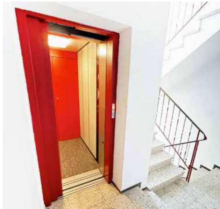
Treppenhaus mit Aufzug
