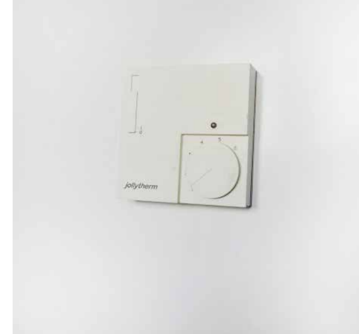
Fussbodentemperierung mit Thermostat im Bad
