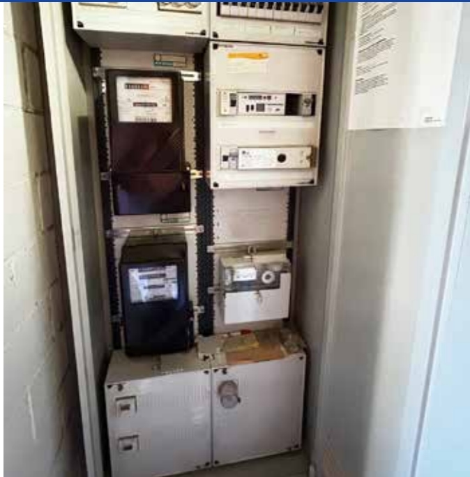
Stromzähler / Sicherungskasten
