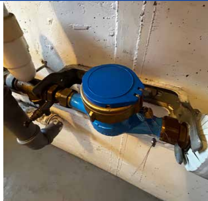
Wasseruhr / Hausanschluß
