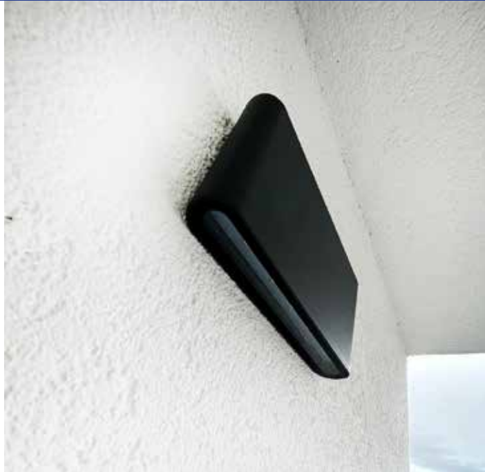
Beleuchtung der Dachterrasse
