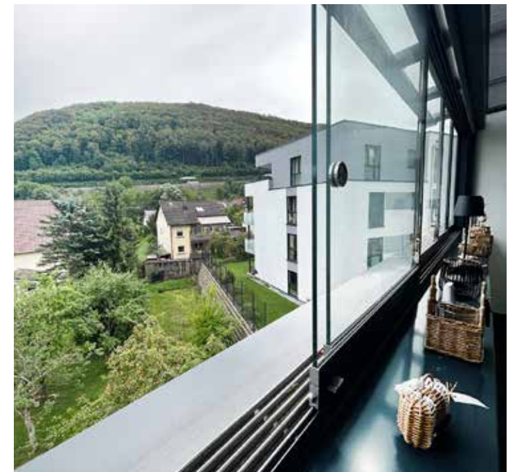
komplett zu öffnende Fenster-Glasfront im Wintergarten
