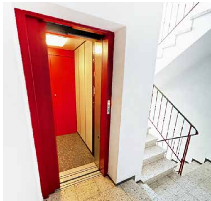
Treppenhaus mit Aufzug
