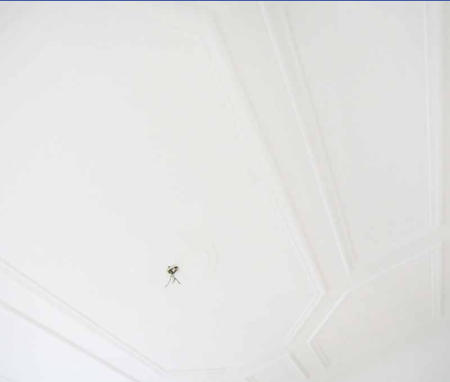
Stuckarbeiten an den Decken
