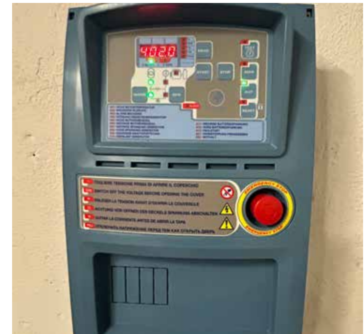
Steuerung Notstrom-Aggregat
