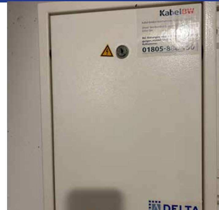
Breitbandkabelanschluss
