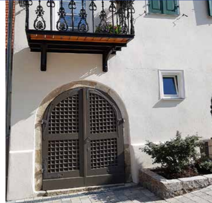
Zugang zum Keller
