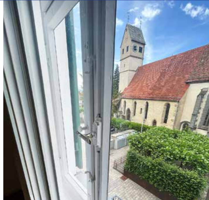
Neue Fenster (dahinter die alten Fenster)
