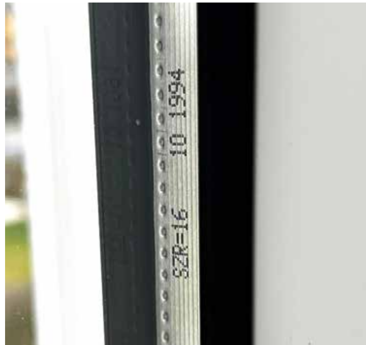
Baujahr & Montagejahr der Fenster
