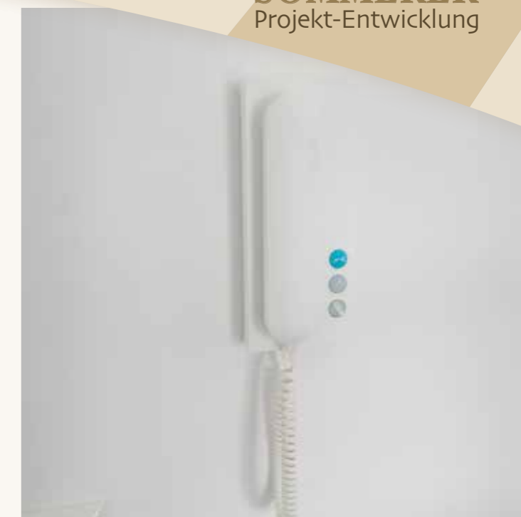
neue moderne „Siedle“ Sprechanlage
