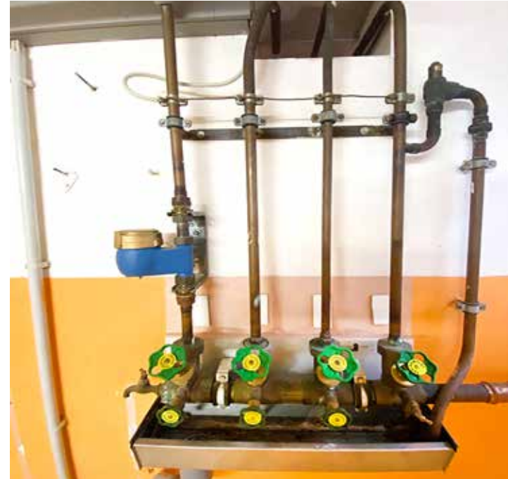
Wasserverteilung in Kupfer Sanitärinstallation
